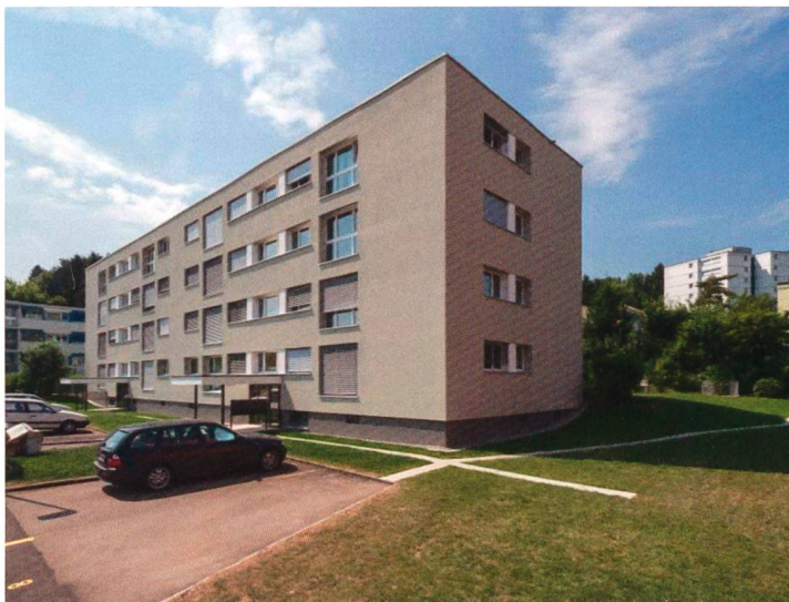
Gesamtsanierung MFH Am Brunnenbächli in Zollikerberg
