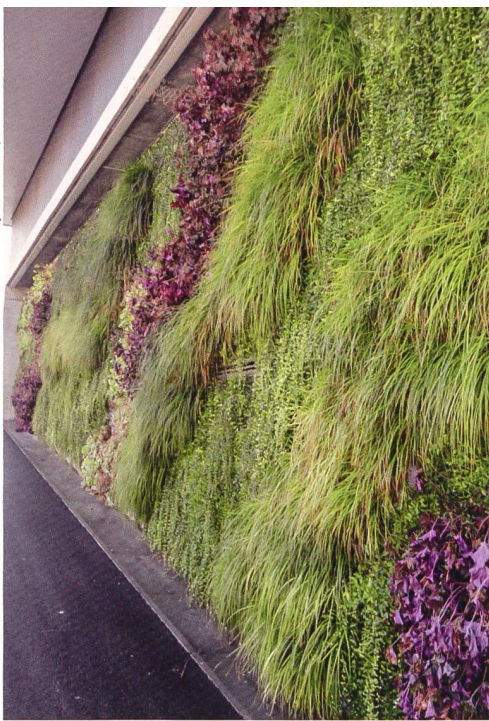
5 Beispiel einer fassadengebundenen Begrünung in Bern. Das System ist von Forster Baugrün.
