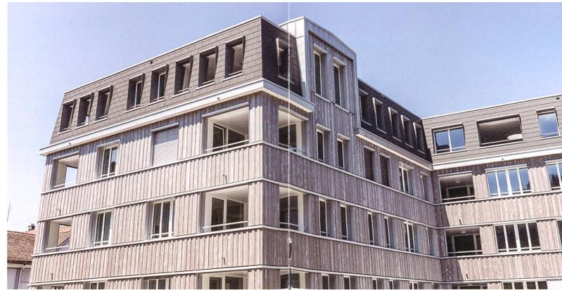
Die Fassadenverkleidung besteht aus vorvergrauter Weissstanne.
