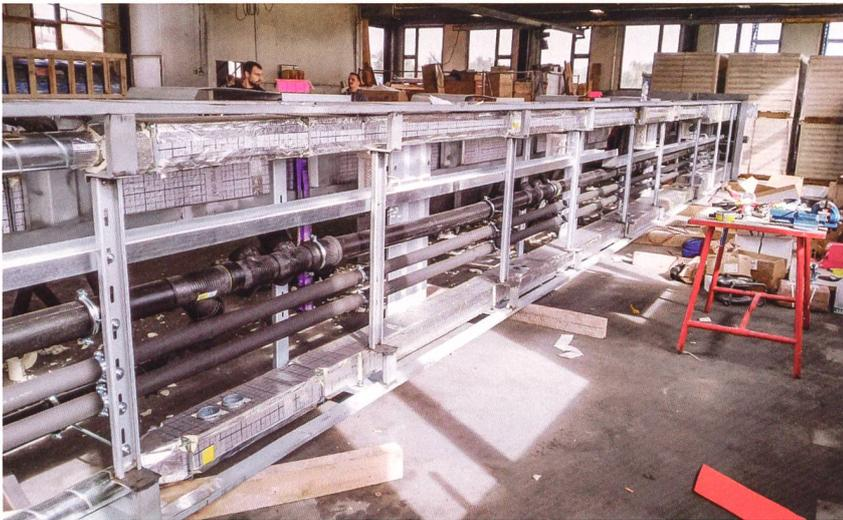
**Das «B & B Airport Hotel» in Rümlang wurde von A bis Z mit Hilfe von BIM geplant und gebaut. Die 18 Steigzonen kamen als 18 Meter lange Module vorgefertigt auf die Baustelle und waren innert 15 Minuten eingebaut.**
