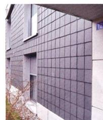
**Vorgehängte hinterlüftete Fassaden sind eine dauerhafte Renovationslösung. Auch optisch kann man dabei Akzente setzen, so wie bei dieser Schieferverkleidung bei einer Siedlung der Gewo Züri Ost.**
