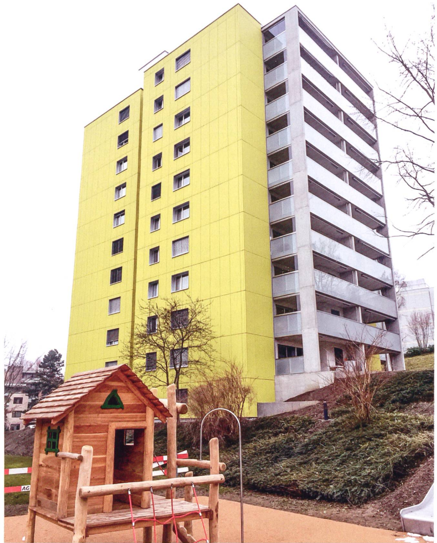
Die GBL wählte gelbe Welleternitelemente für die Erneuerung ihres Hochhauses Kleingli in Schlieren (ZH). Links: früherer Zustand mit Gebäudehülle aus Modulbacksteinen.
