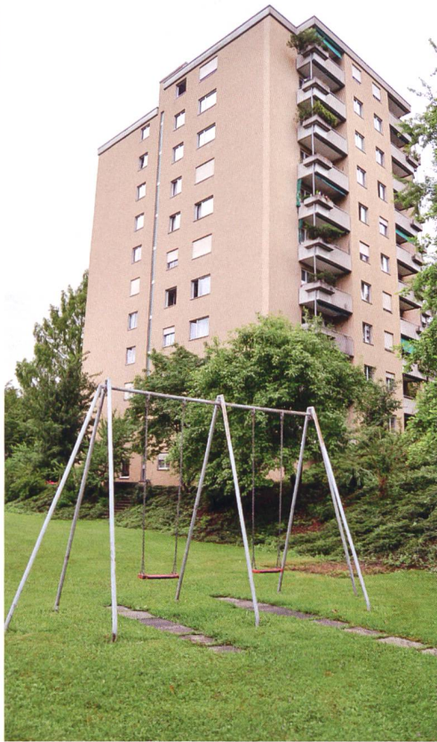
Die GBL wählte gelbe Welleternitelemente für die Erneuerung ihres Hochhauses Kleingli in Schlieren (ZH). Links: früherer Zustand mit Gebäudehülle aus Modulbacksteinen.
