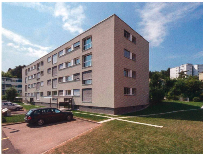
Gesamtsanierung MFH Am Brunnenbächli in Zollikerberg
