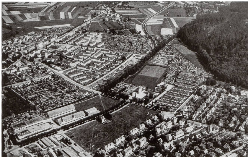
Hochburg des genossenschaftlichen Wohnungsbaus in Winterthur ist der Stadtkreis Mattenbach, der nach dem Zweiten Weltkrieg wesentlich von gemeinnützigen Organisationen geprägt wurde.
