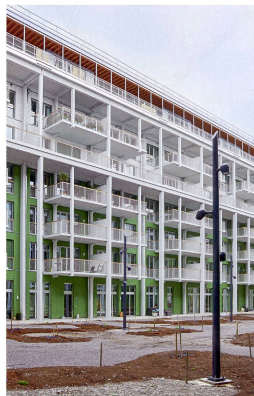
Ein Grossteil des Gemeinschaftslebens wird im 2000 Quadratmeter grossen Innenhof stattfinden. Hier ist ersichtlich, dass der Bau zu grossen Teilen aus vorgefertigten Holzelementen besteht.
