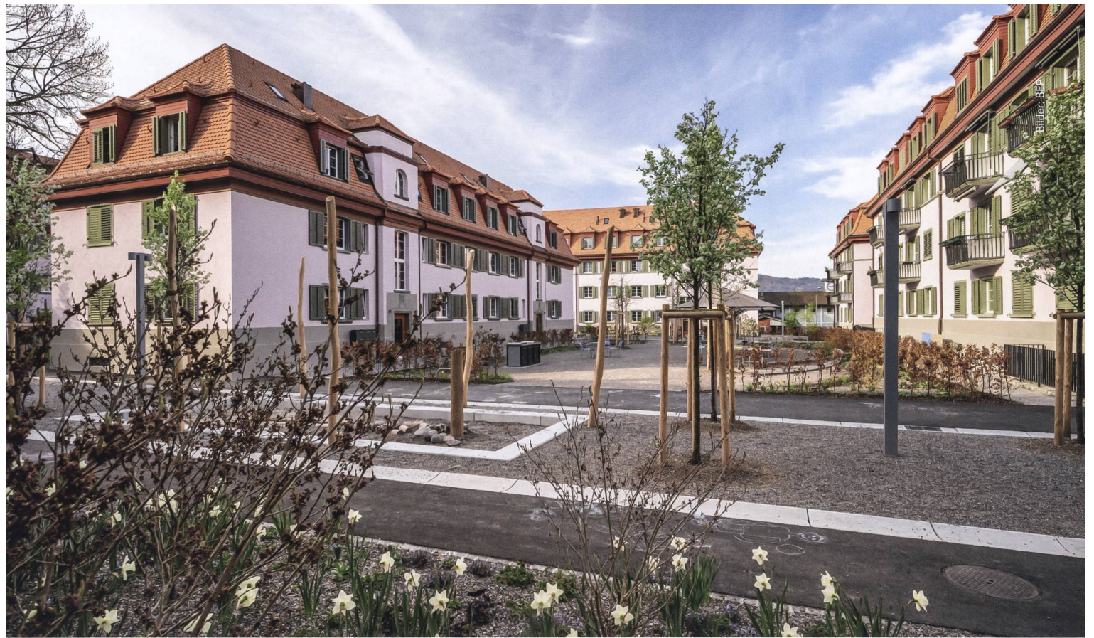
Die 13 Mehrfamilienhäuser der Siedlung Letten 4 präsentieren sich von aussen wieder wie zur Entstehungszeit 1925. Sie haben auch wieder ihre ursprüngliche Farbgebung erhalten.
