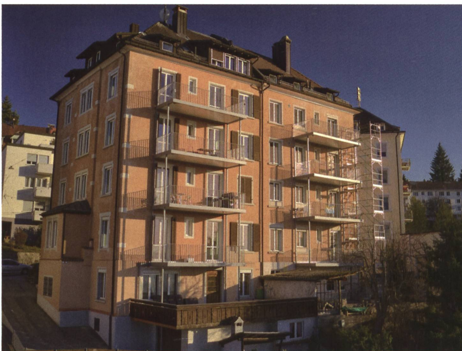
Referenzobjekt St. Gallen – Total 8 Balkone.
