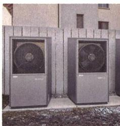
wird sich ändern. Als grosser Gebäude-technikanbieter empfiehlt die Meier Tobler AG für die Umrüstung kleinerer Mehrfamilienhäuser eine Luft-Wasser-Wärmepumpe. Der Vorteil einer solchen liegt vor allem darin, dass die Installation mit geringem baulichem Aufwand verbunden ist. Je nach Grösse der Liegenschaft kann mit einer Dreierkaskade die Leistung erhöht werden. Gegen den Schall schützt etwa eine Steinpalisade.
