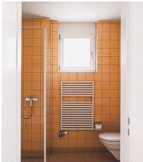
Im Erdgeschoss wurden einige Badezimmer barrierefrei mit schwellenloser Dusche ausgestattet. Die Duschwand lässt sich im Bedarfsfall einfach entfernen. Bei Farben und Plattenformaten hat man sich an die Gestaltung der 1980er-Jahre angelehnt.
