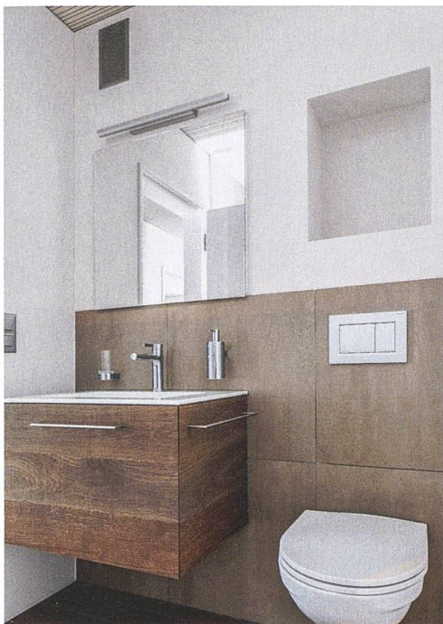
Belüftet man Wohnungen im Kaskaden- oder Verbundsystem, wird die verbrauchte Luft in der Küche und im Bad durch ein Auslassgitter abgesogen.
