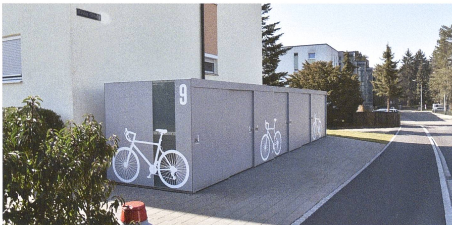
Velogarage Wohnbaugenossenschaft Kohlplatz, Rheinfelden
