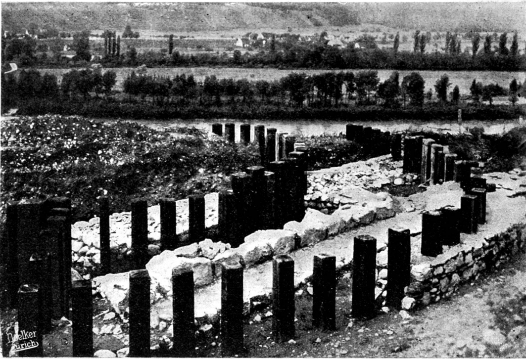
21. Wallmauer östlich vom Lagertor, mit dem erneuerten Pfahlwerk.
