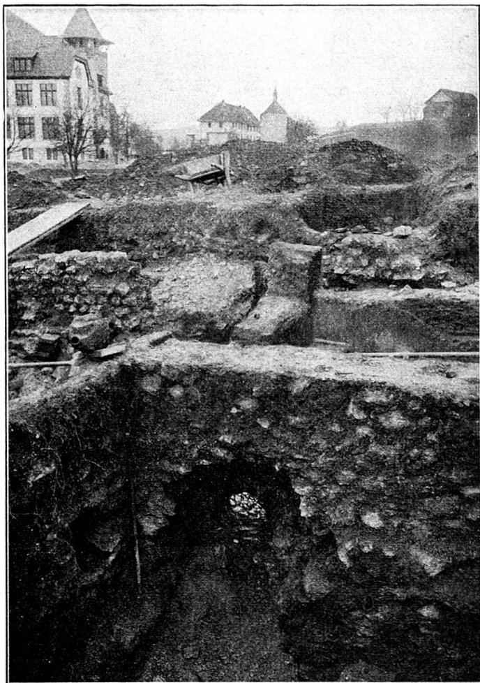
58. Niedergösgen. Ansicht der Nordostmauer des Raumes B, von aussen. (Links von der Mitte die Röhre.)
