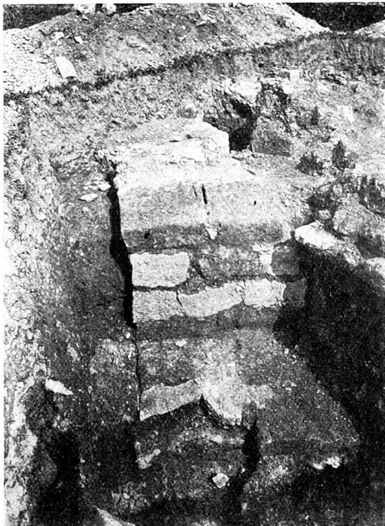
Abb. 13. Wallmauer mit Pforte.
