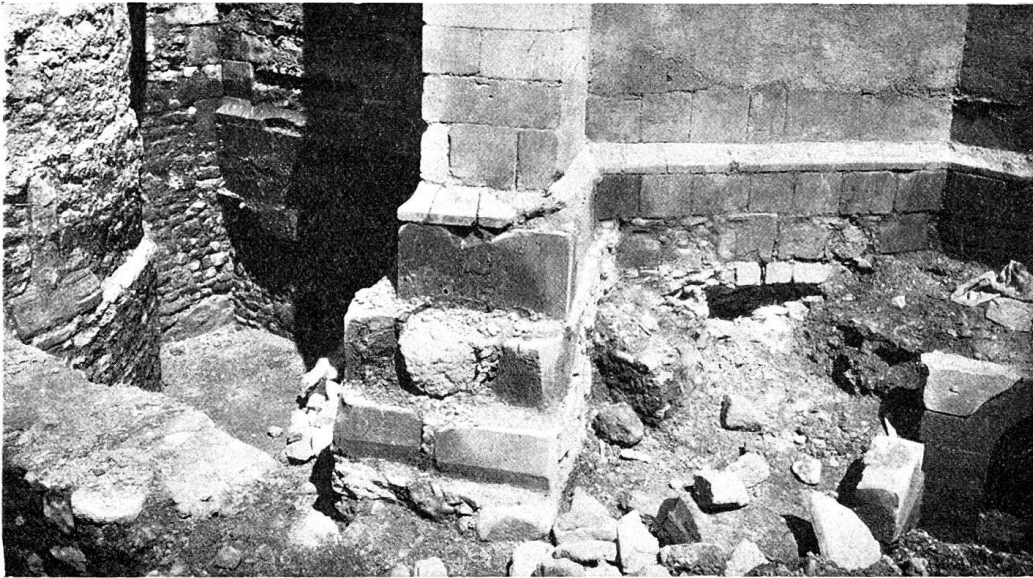
Abb. 19. Südost-Ecke des Chores, von aussen. (Links die Apsis des südlichen Querflügels; in der Mitte der südöstliche Strebepfeiler; rechts unten Reste der romanischen Krypta, vgl. Abb. 18.)
