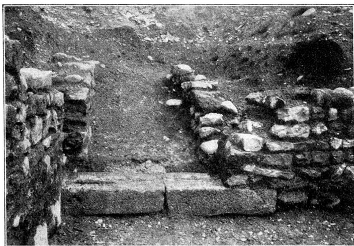
Abb. 4. Bau I im Steinacker, 1911: Zugangsrampe mit Seitenmauern und Steinschwelle. Aufnahme von Dr. Pfenniger.
