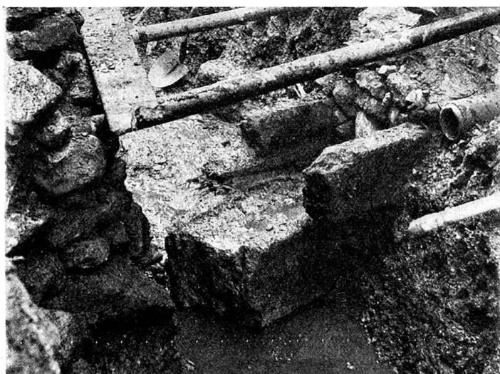
Fig. 6. Canalisation de la source, à trois époques.
