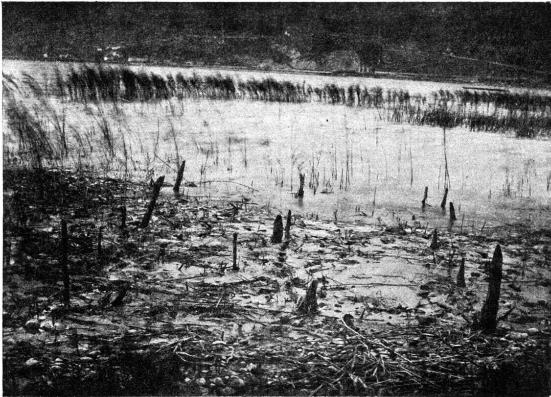
Abb. 4. Kleines Pfahlhaus der neuen Station Sutz 1) .
