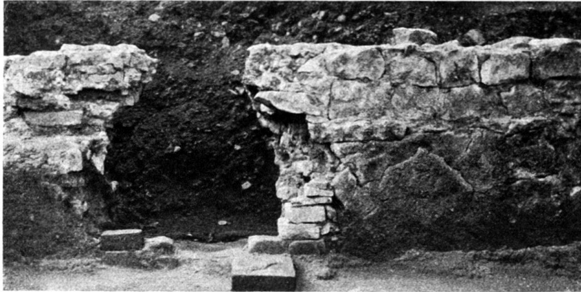
Abb. 9. Mauertechnik der II. Periode.
