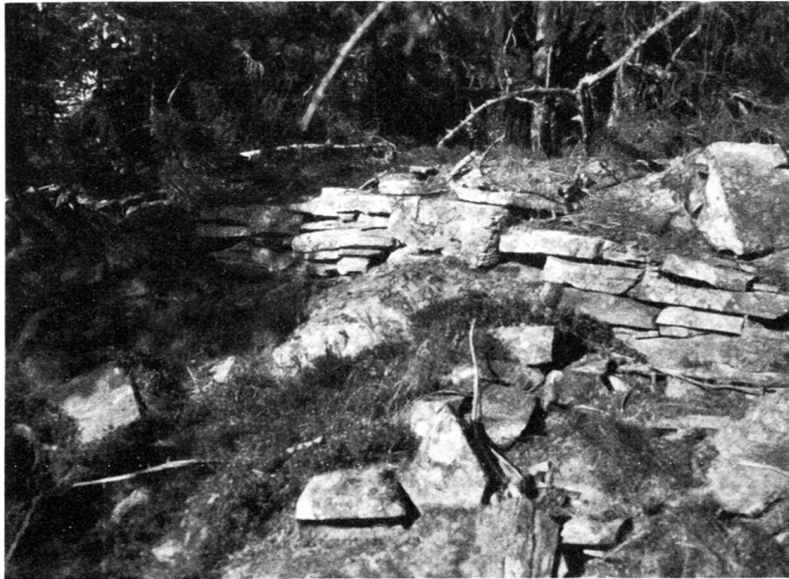
Abb. 3. Muotta da Clüs. Nordwestecke der Umfassungsmauer.
