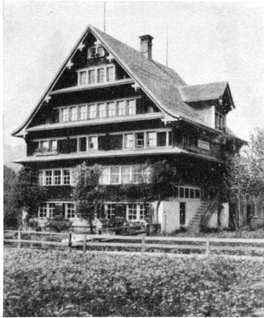
Abb. 2. Wohnhaus Joseph Loosers, erbaut i. J. 1781, in Lüpfertwil, Kappel
