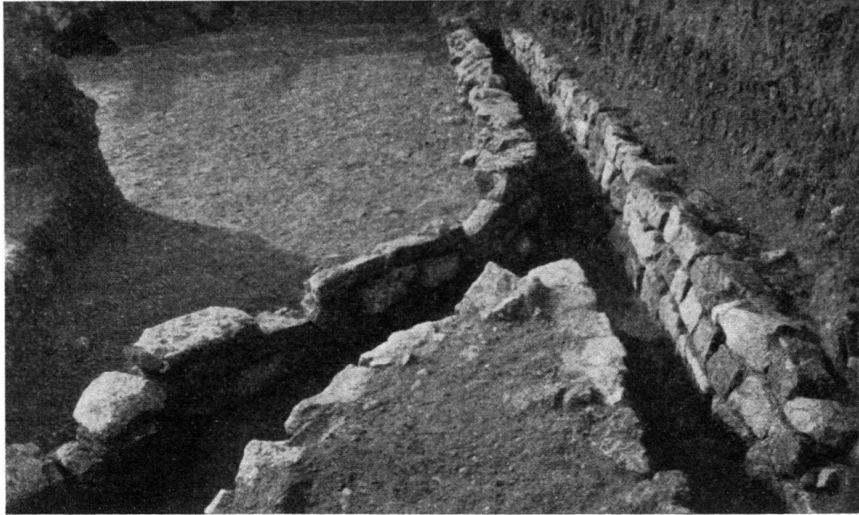
Abb. 12. Gemauerte Abzugskanäle
