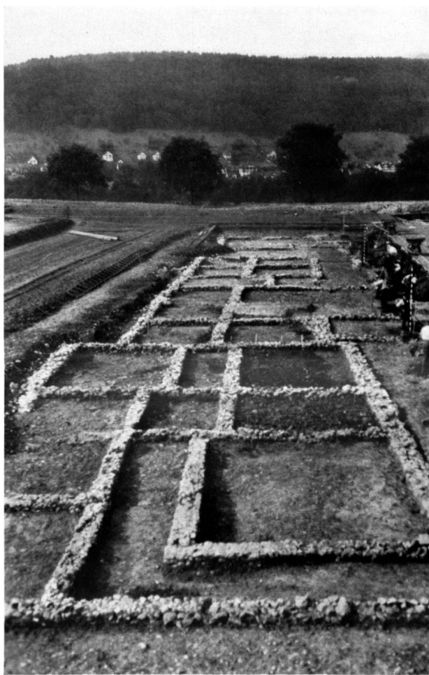
1. EINE DER KLEINERN KASERNENANLAGEN: IM VORDERGRUND DAS UNTEROFFIZIERSHAUS OBEN DER MANNSCHAFTS- TRAKT
