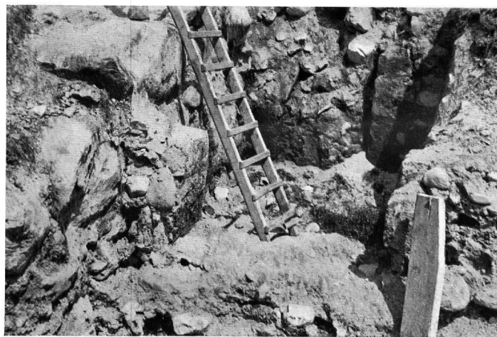
Abb. 3. Vermauerte Türe der Südwand
