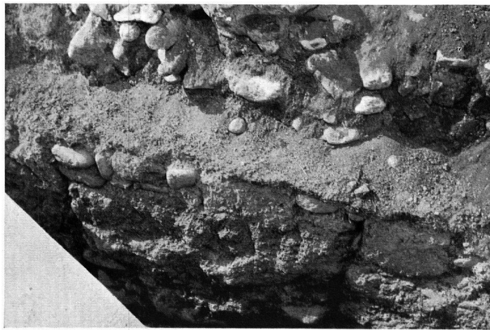
Abb. 2. Eingang gegen den Bergfried und vermauerte Türöffnung
