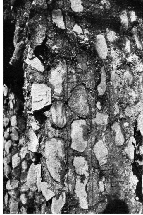
4. Ansicht eines Teilstückes der Ostmauer von Raum 4 (2. Bauperiode)
