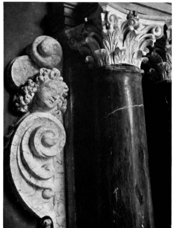
a Vorhalle der barocken Kapelle in Tammatten bei Saas Grund. Säulen aus grober Rauhwaacke. b Taufstein in der Kirche Sursee, um 1640. Schwarzer Marmor (dunkler, polierter Alpenkalkstein), hier mit deutlicher Brekzienstruktur. c Grabmahl von Erlach in der Kirche Schinznach Dorf, um 1650. Der helle Alabaster an Kapitell und Plastik wirkungsvoll mit den Säulen aus dunklem Alpenkalkstein kontrastierend.
