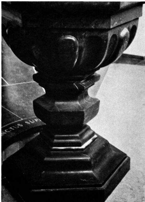
a Vorhalle der barocken Kapelle in Tammatten bei Saas Grund. Säulen aus grober Rauhwaacke. b Taufstein in der Kirche Sursee, um 1640. Schwarzer Marmor (dunkler, polierter Alpenkalkstein), hier mit deutlicher Brekzienstruktur. c Grabmahl von Erlach in der Kirche Schinznach Dorf, um 1650. Der helle Alabaster an Kapitell und Plastik wirkungsvoll mit den Säulen aus dunklem Alpenkalkstein kontrastierend.
