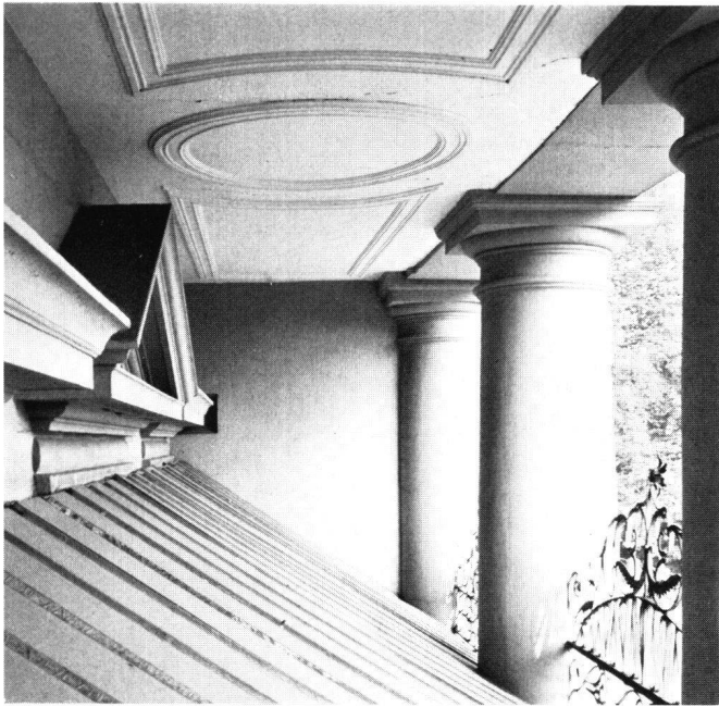
Fig. 10 Fribourg, château de La Poya: fronton et corniches au-dessus des portes et baies du salon, côté portique; observer la niche où s'engage la corniche; pan de verre du début de ce siècle
