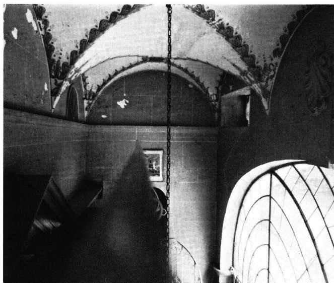
Fig. 8 Fribourg, château de La Poya: porche, partie supérieure, vue vers l'ouest (le flou du centre est produit par la barrière de la galerie de circulation); à gauche, fronton surmontant la porte et corniche engagée; voûte d'arêtes; à droite, oculus et coquille à la clé de l'arche; au centre, à demi-cachés, porte et escalier du début de ce siècle
