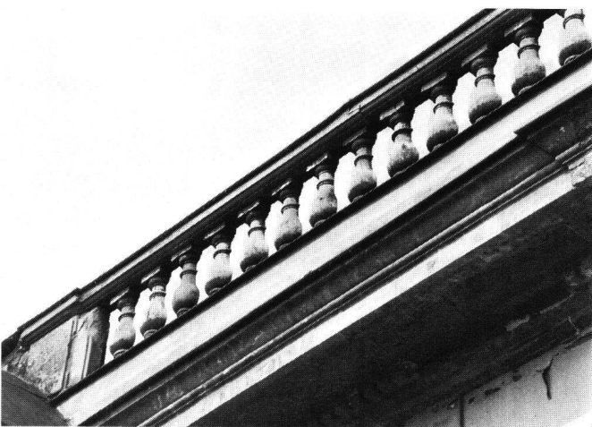
Fig. 15 Fribourg, château de La Poya: demi-balustres de bois, façade sud
