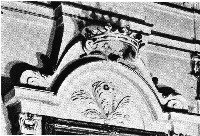
Abb. 14 Fribourg, Château de La Poya: Segmentgiebel der Ostwand
