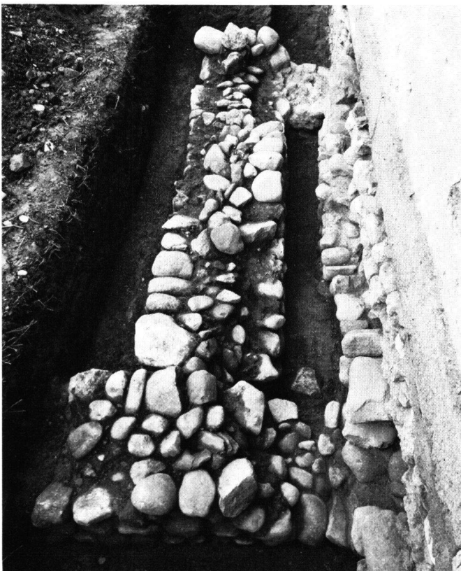
Fig. 11 Mur nord du transept, vue vers l'est; au premier plan un mur romain récupéré
