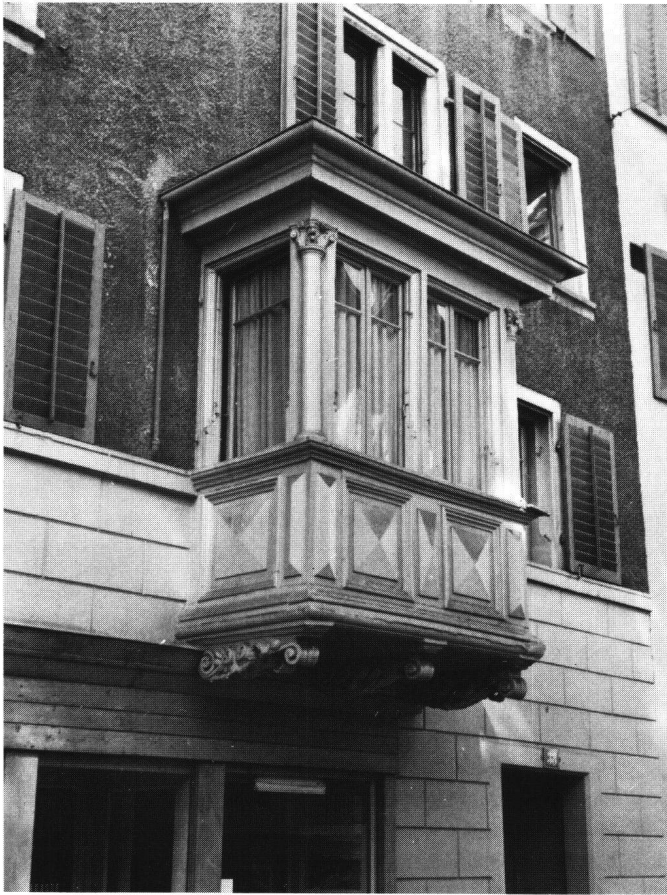
Abb. 15 Rechteckiger Erker auf drei geschnittenen Konsolen mit Voluten und Blattwerk. Die beiden Ecken werden durch korinthische Säulen über Sockeln ausgezeichnet. Die Brüstungsfelder weisen facettierte Quader auf. 2. Hälfte des 17. Jahrhunderts.
