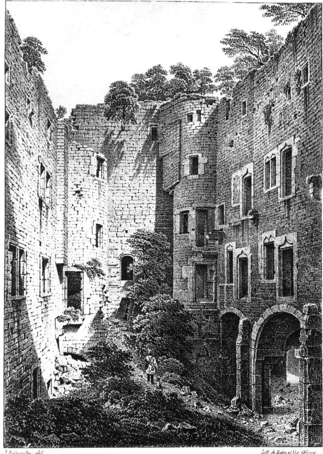
Abb. 4 Die Ruine 1839. Innenhof (Ehrenhof) mit Blick nach Osten auf den Bergfriedstumpf mit staufischem Buckelquaderwerk und Zangenlöchern im unteren Teil. Im Zwickel von Bergfried und Südpalas (rechts) der Ort des eingestürzten und von Ebhardt rekonstruierten Treppenhauses (vgl. Abb. 10).
