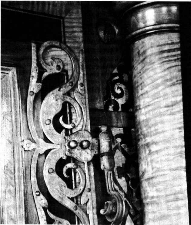
Abb. 6 Scharnierbeschlag der Eingangstür.
