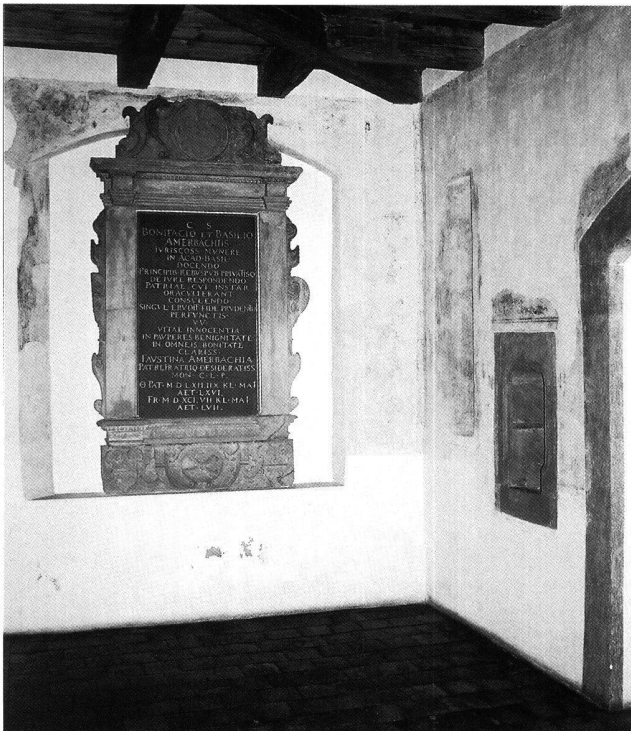
Abb. 2 Blick in die nordöstliche Ecke des Kleinen Kreuzganges der Kartause mit der Wandnische des verlorenen Johannesaltars (darin das Wandepitaph für Bonifacius Amerbach und seinen Sohn Basilius). Die Aussparungen an der Wand (rechts, zur Kirche hin) und an der linken Kante der Nische nahmen auf die beweglichen Aussenflügel des Altars Rücksicht.
