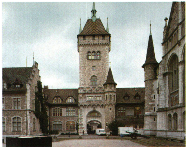
Abb. 1 Teilansicht vom Innenhof auf das Schweizerische Landesmuseum Zürich. Eingangsturm und rechts anschliessend die Ruhmeshalle.
