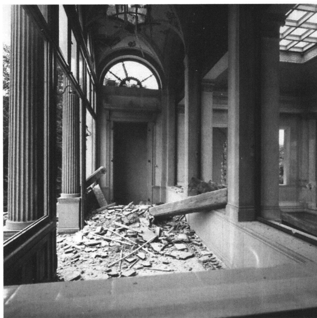
Abb. 10 Villa Seeburg, Treppenhalle beim Abbruch. Aufnahme 29. Juli 1970.
