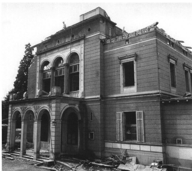
Abb. 9 Villa Seeburg während der Abbucharbeiten. Aufnahme 29. Juli 1970.
