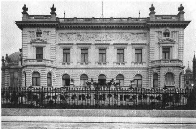
Abb. 13 Palais Henneberg, Hauptfassade gegen den See. Aufnahme 1898.
