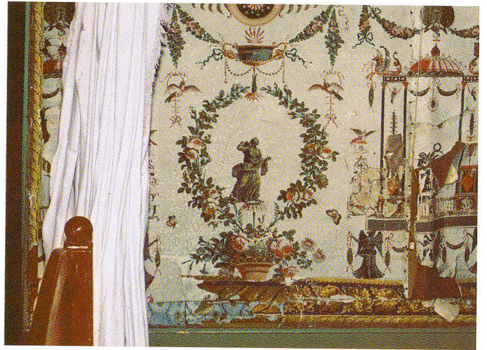
Abb. 14 Ausschnitt des Arabeskenensembles in Trois-Rods. Am rechten Bildrand die überlappend mit Nägeln befestigten Teile. Am unteren Bildrand, links von der Mitte der angestückte Rand. Rechts davon und am linken Bildrand je zwei der insgesamt vier Bordüren, Situation 1983.
