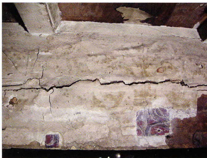
Fig. 4 Les premiers échantillons dégagés nous font découvrir le papier et sa riche polychromie.
