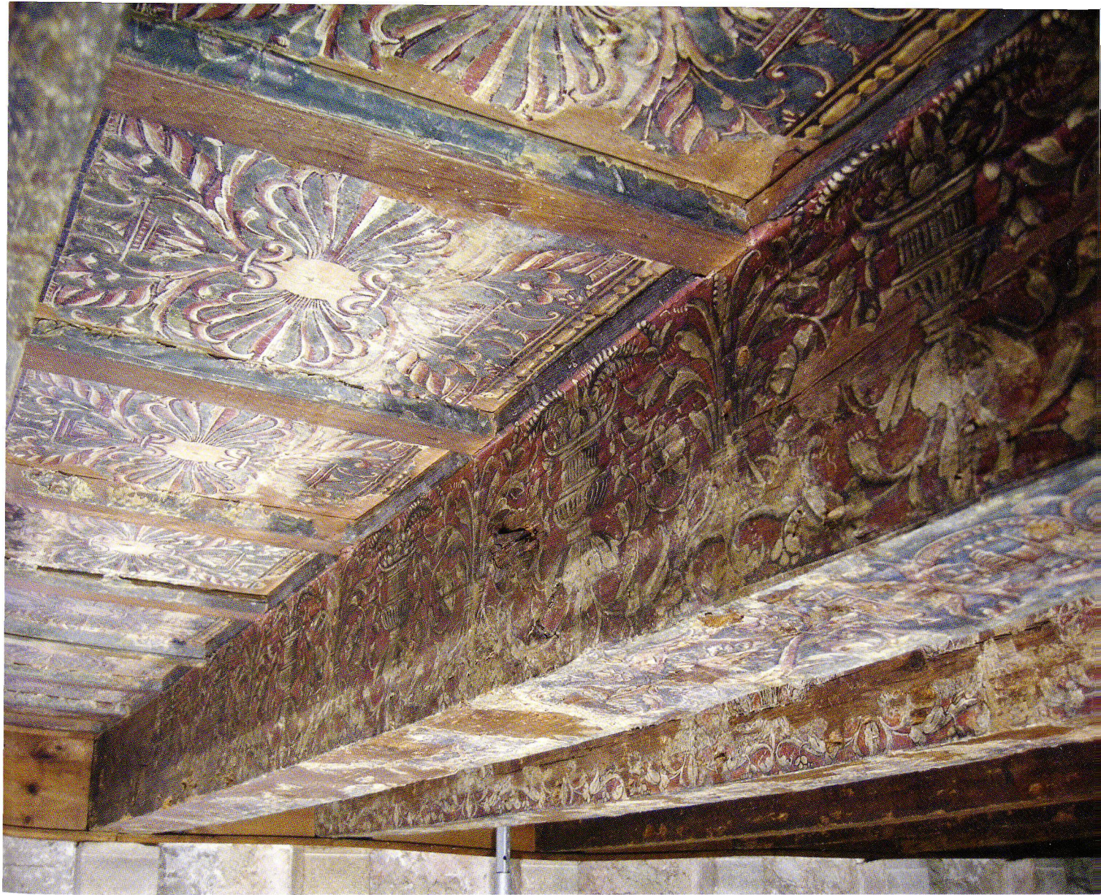
Fig. 12 Détail après la restauration.
