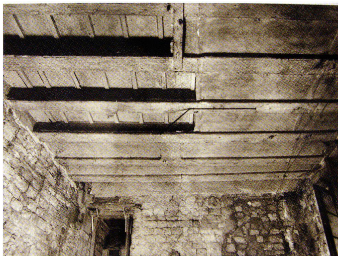
Fig. 5 Vue du plafond avant le début des travaux en 1960.
