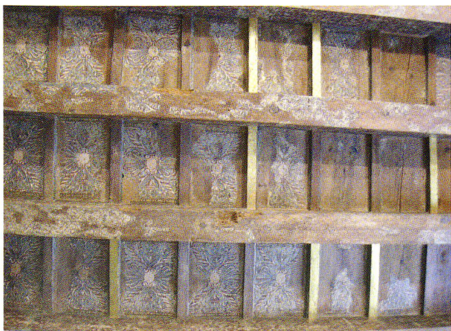
Fig. 13 L'ensemble après la restauration.
