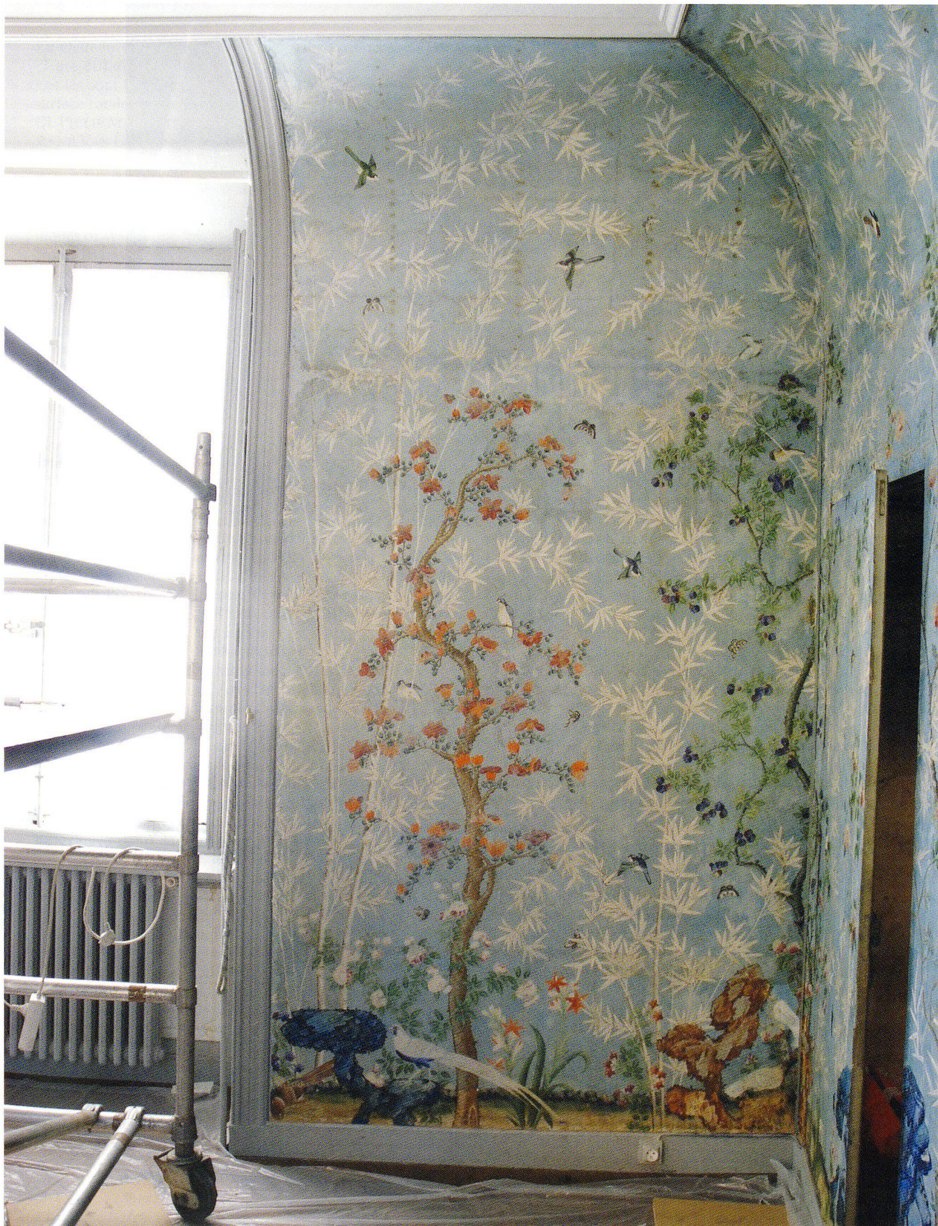
Fig. 8 Le mur après repose.
