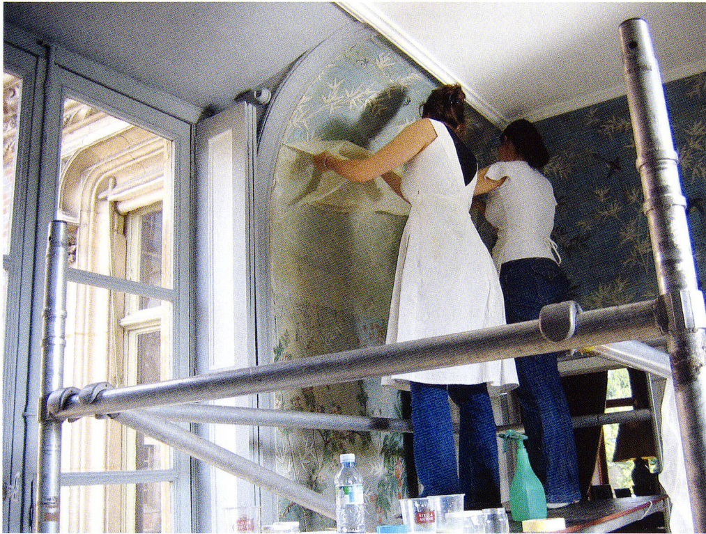
Fig. 9 Le nettoyage par capillarité.
