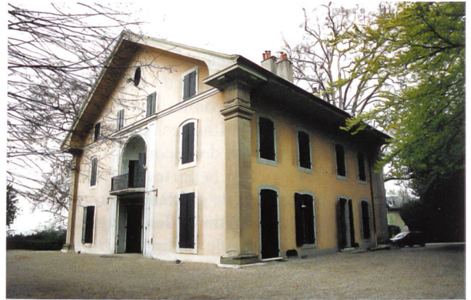
Fig. 14 La façade côté jardins de l'ancienne maison Calandrini à Frontenex ; état avant restauration, 2003.
