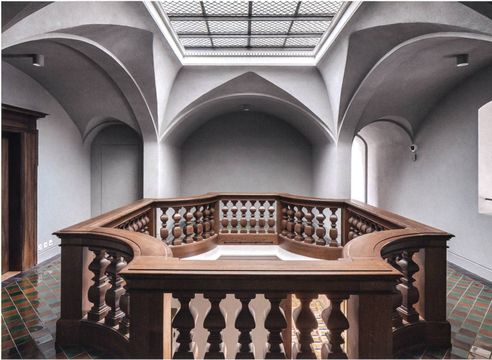
Abb. 5+6 Der wiederhergestellte Deckendurchbruch im Vorraum Obere Kapelle,
