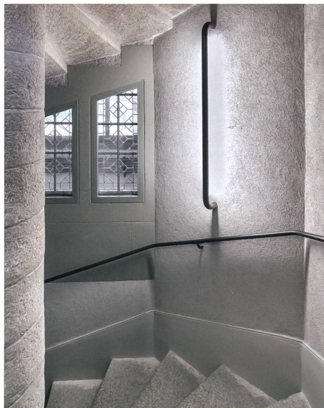
Abb. 3 Die neue Sonderleuchte im Westflügel.
