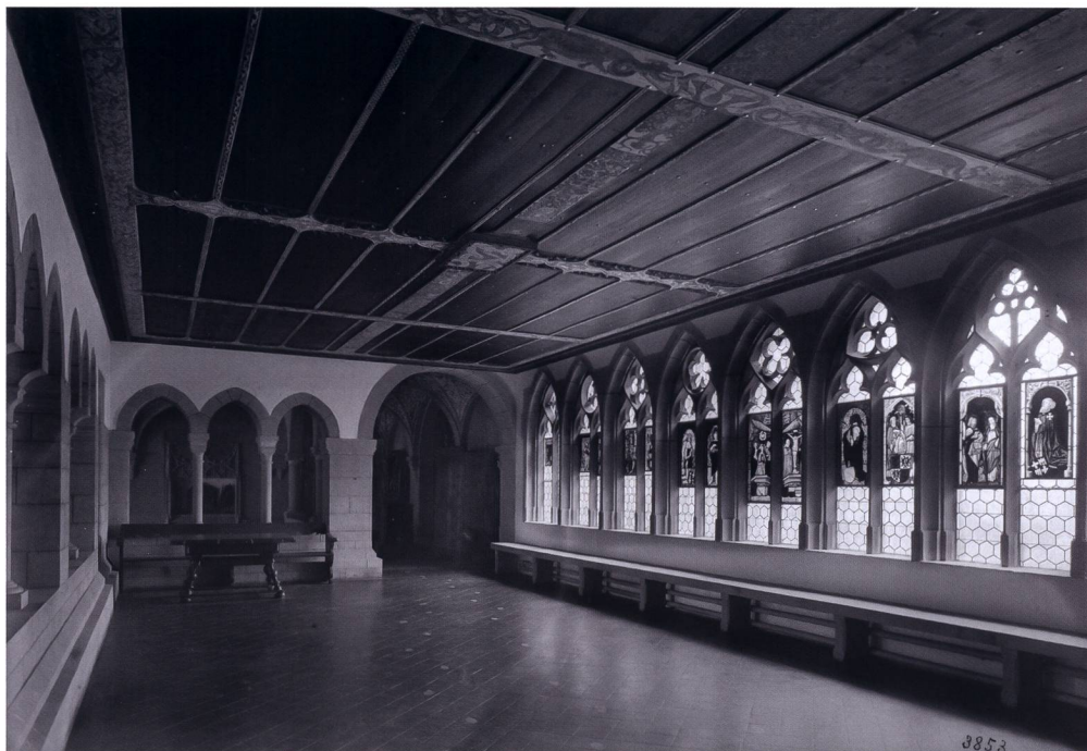
Abb. 2 Masswerkfenster im oberen Kreuzgang (Raum 15), ehemals aus dem Barfüsserkloster Zürich, Aufnahme um 1900. Schweizerisches Nationalmuseum, DIG 30097.
