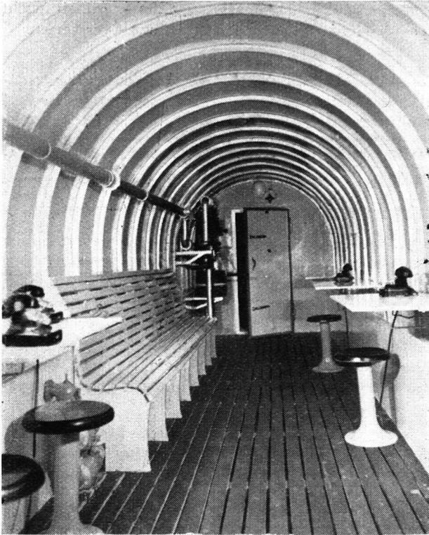
Innenansicht eines Schutzraumes, welcher als Befehlsstand einer Luftschutztruppe dient. — Hinten links: Filter mit Raumbelüftungsanlage.
