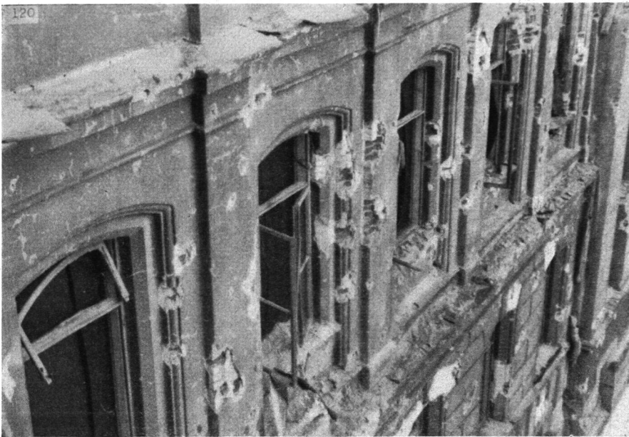
Abb. 5. Unter Splitterwirkung «ausgewaschene» Fassade.
