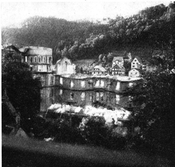
Sprengung eines Gebäudeteiles (Baden)
