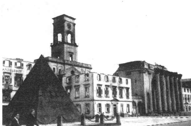
Ausgebrannte Massivbauten im Zentrum von Karlsruhe.
