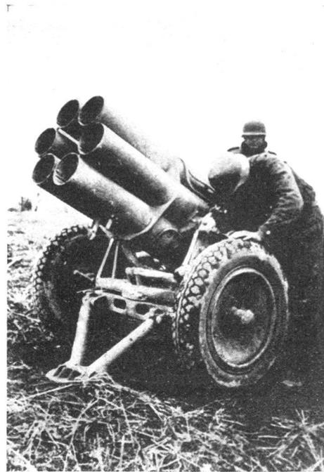
Deutscher 15-cm-Raketenwerfer mit sechs Rohren auf Fahrgestell.
